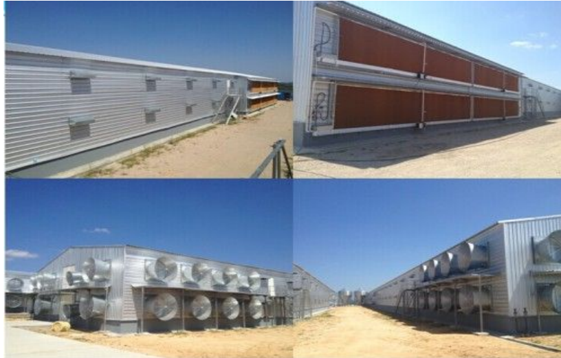
Figure 03 : les extracteurs et les humidificateurs [2]
