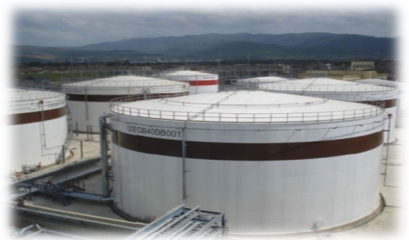
Figure 1.12. les réservoirs fuel.
