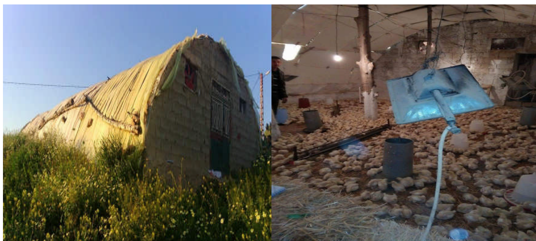
Figure n°14 : Bâtiment d'élevage 2 (B2), vu d'extérieur et intérieur.
