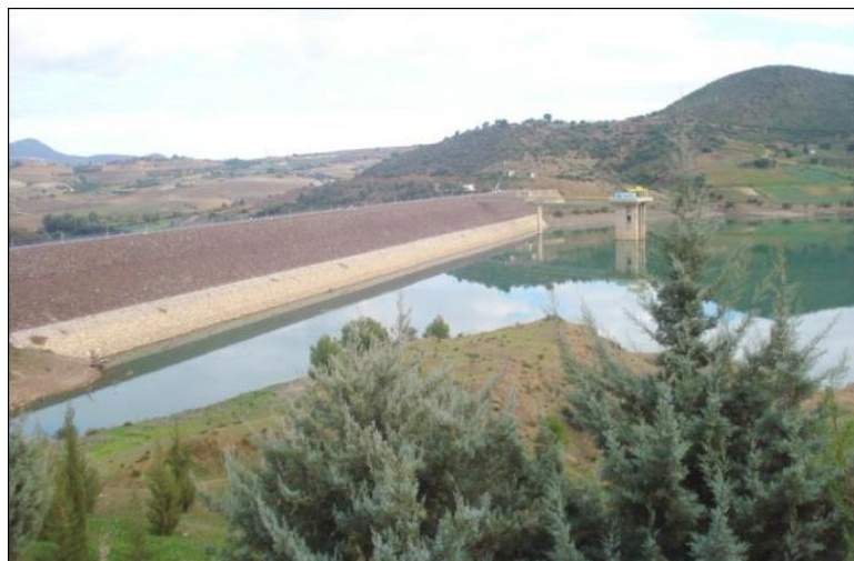
Figure 12 : Digue en enrochement du barrage réservoir de Boukourdane (Photo. Remini, 2007)
