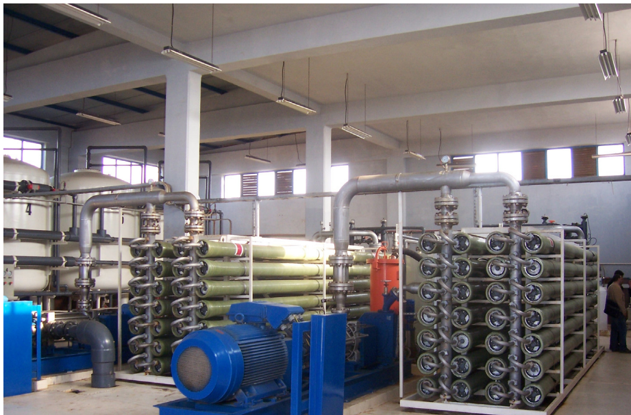
Station en Algérie type monobloc par osmose inverse
