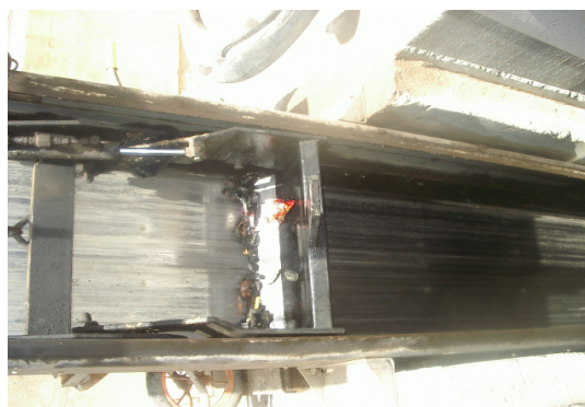
Dégrillage de gros déchets solides au niveau de la SR2
