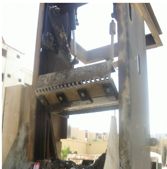
Dégrillage de gros déchets solides au niveau de la SR2
