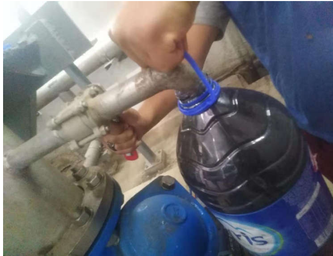
Figure 3 19:boues de stations d'épuration baraki .
