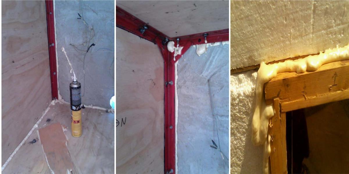
Photo3.22: isolation par mousse polyuréthane.
