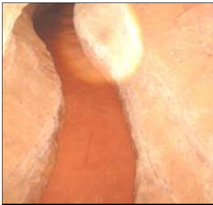
Figure 30:Galerie (photos prises sur site )
