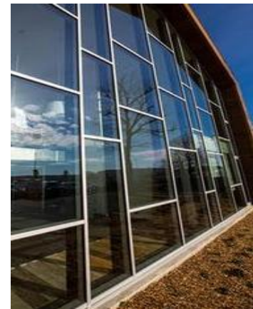
Figure 70 : photo d'une façade avec mur-rideau Source : www.batiproduits.fr
