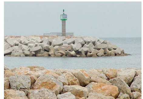
Figure 19 : Aménagement en enrochement d'Argelès, France Source : http://oceanogeo.veille.inist.fr/
