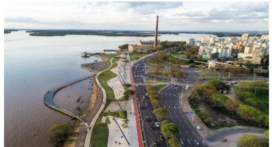
Figure 10 : Vue aérienne de la promenade de Porto Alegre, Rio Grande do Sul, Brasil Source : https://www.archdaily.com
