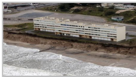
Figure 35 : Le Signal à marée basse à Soulac.
