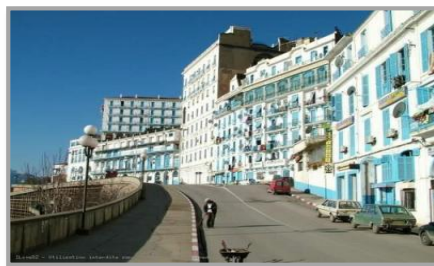
Figure 42 : façade maritime de la ville de Bejaïa, Algérie
