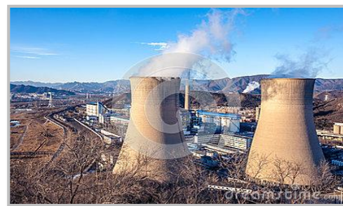
Figure 17: tour de refroidissement d'usine d'industrie lourde à Pékin
