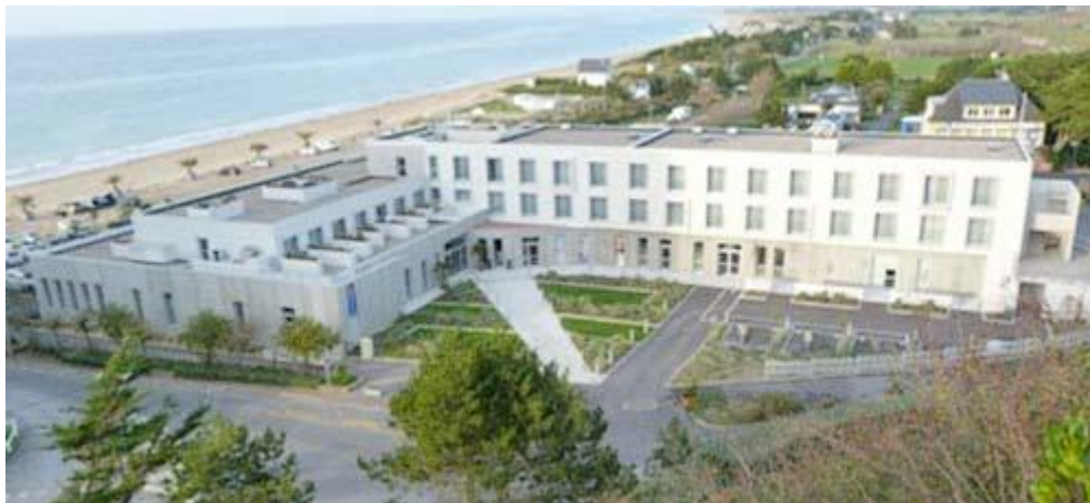
Figure : vue générale sur le centre de thalassothérapie Donville-les-bains
