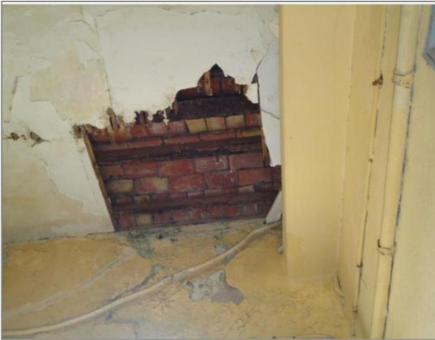
**Fig. 276 :** Solives métalliques avec des briques creuses comme remplissage, dans l'ancienne banque
