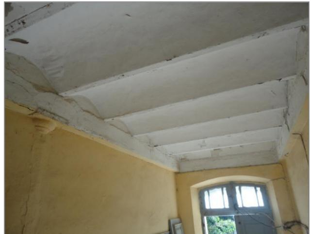
**Fig. 277 :** Profilés métalliques couverts d'une couche de plâtre, dans l'ancienne école des
