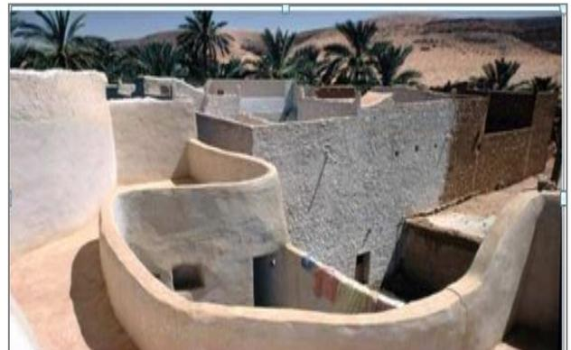
Fig. 29 : Mur épais à haut inertie thermique
