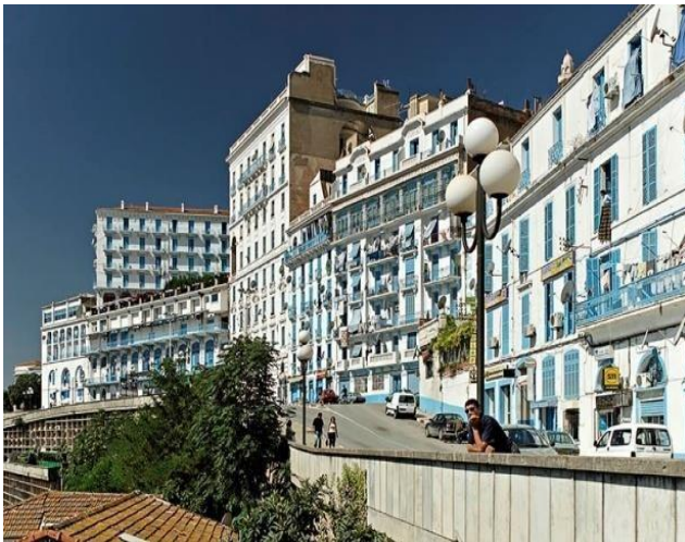
Image 01 : Le bleu et le blanc dans les façades dans la ville de Bejaia. Source : https://bejaia-city.skyrock.com , consulté mai 2018
