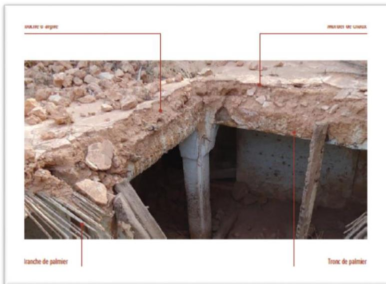
**Figure 123 :** Composants du plancher
