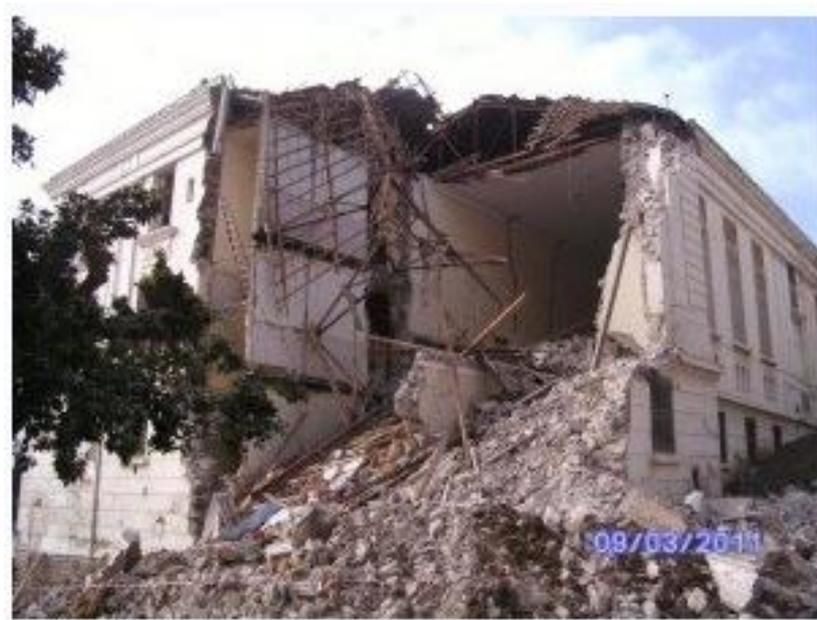
Figure 49 : fissuration de l'aile droite de l'ex tribunal
