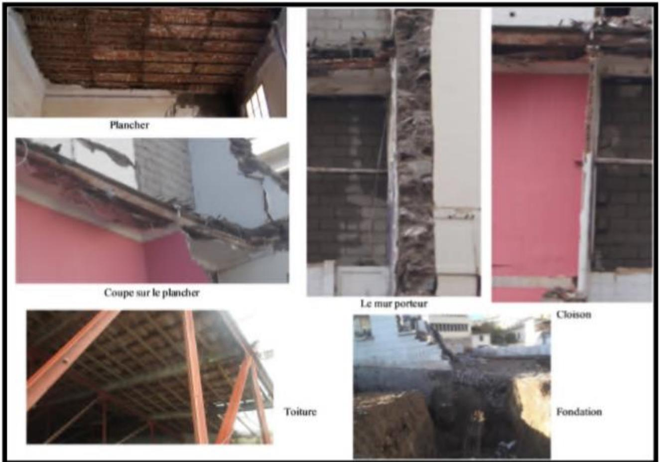
Figure 59 : Vues sur les différents éléments systèmes constructifs
