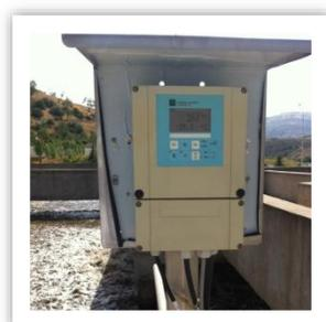
**Figure.54 Oxymètre fixe**
