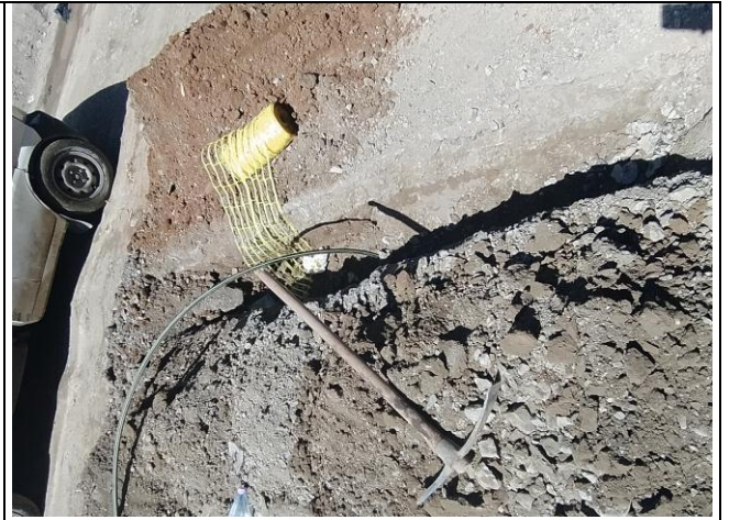
Fig. 32 : code couleur pour le réseaux gaz
