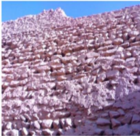
Fig. 07 mur en pierre
