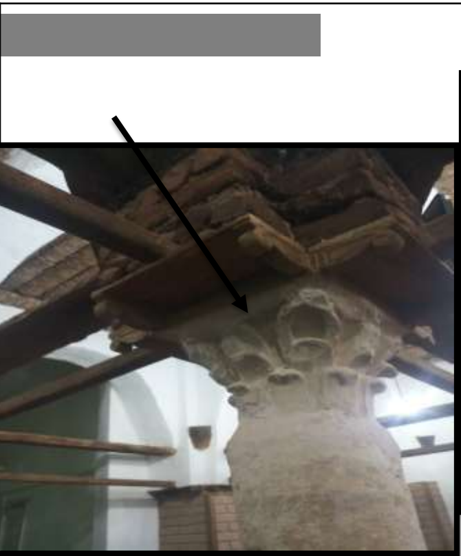
Fig.37: Traces de colonnes romaine a l'intérieur de la mosquée msid avec des chapiteau décorés à l'intérieur
