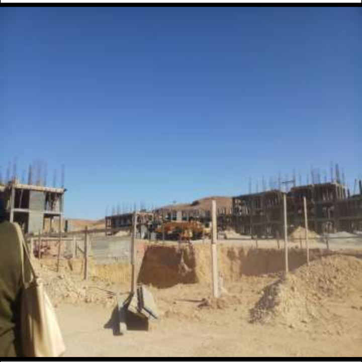
Fig.31: vue sur une construction au pole1 avec technique poteaux-poutre
