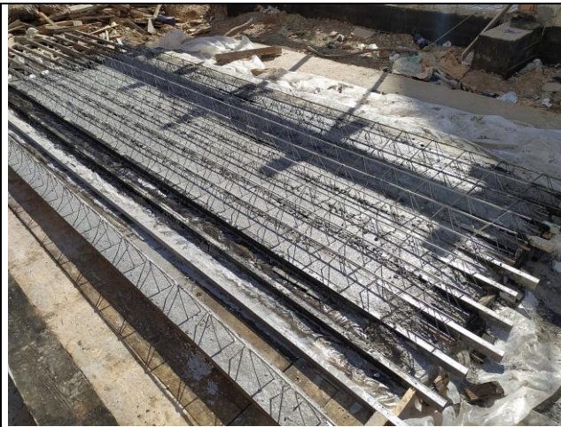
Fig. 21 : la mise en œuvre des poutrelles
