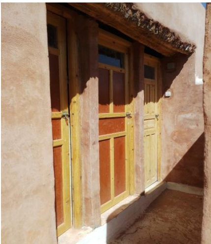
Fig. 63 Les sanitaire au 1ère étage
