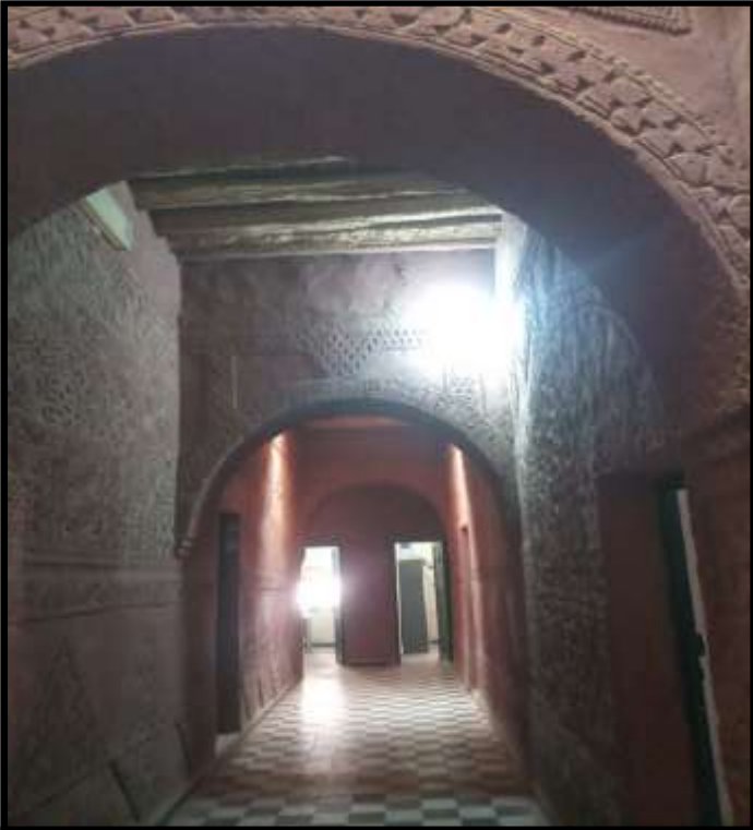
Vu intérieur du centre avec le système porteur en arcs et plancher avec palmiers
