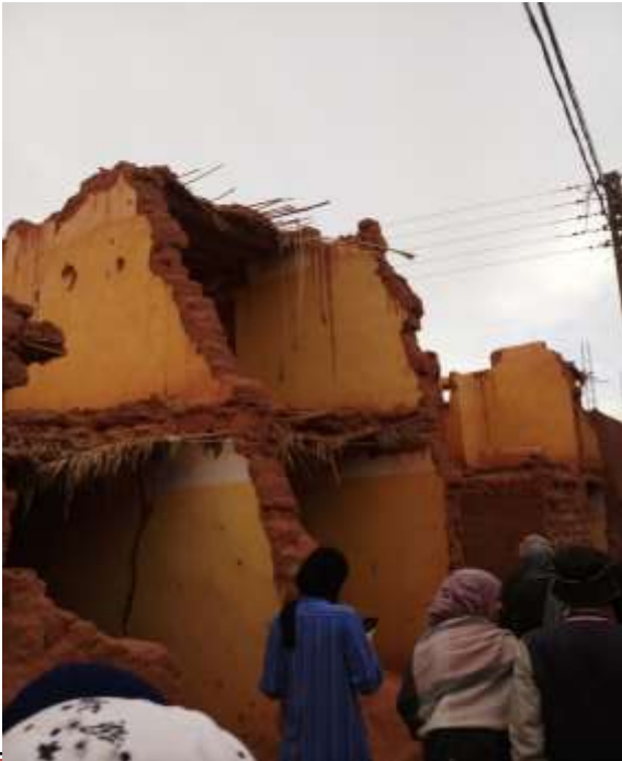
Fig.1: vu sur les construction délabré de ksar beni mehlel
