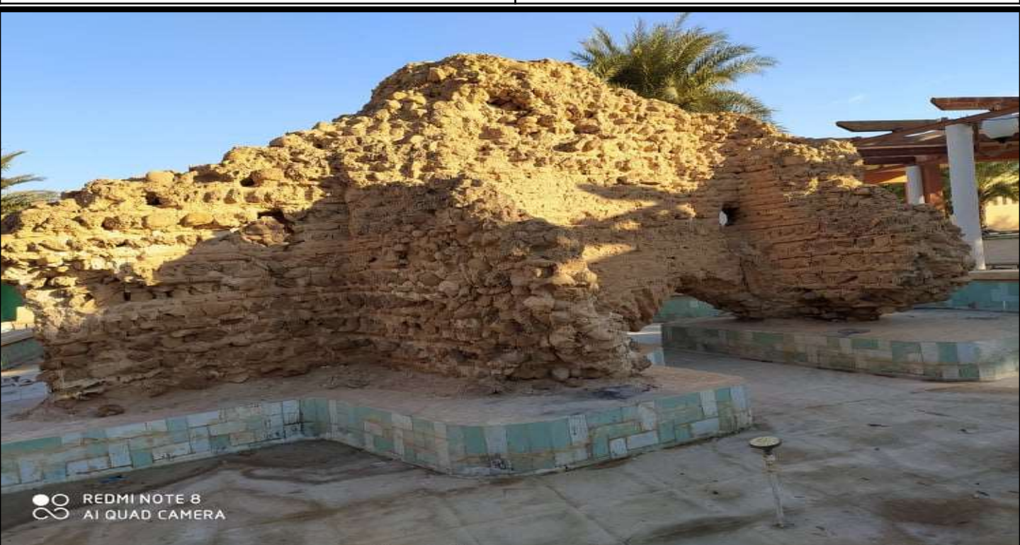
Fig.18: traces de ruines romaines avec une traces d'arc l'eau et la mauvaise installation du sous bassement font que ce vestige se délabre de plus en plus
