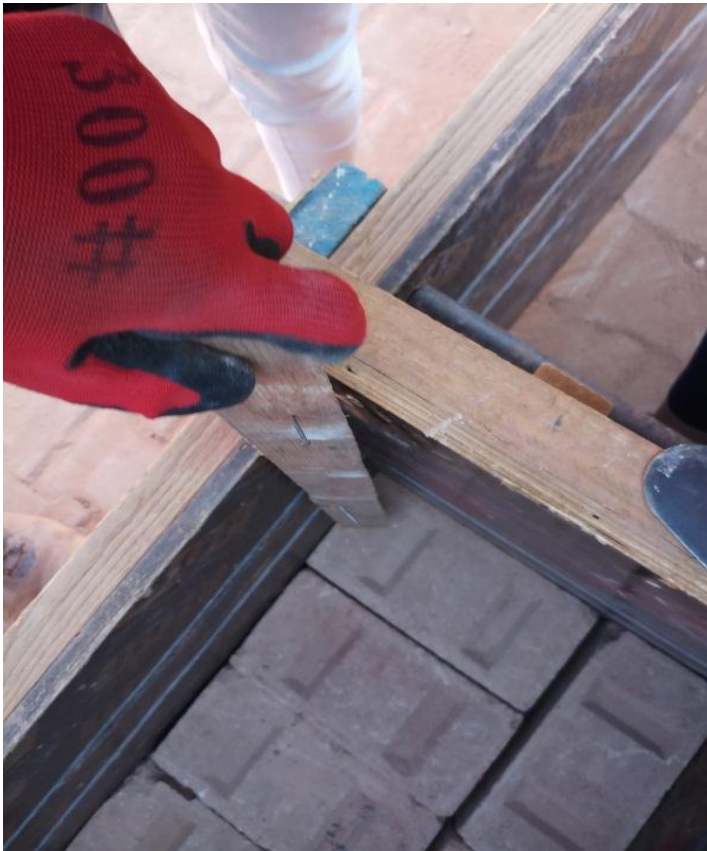
Fig. 70 la pratique de la construction d'un mur avec la technique de le pisé
