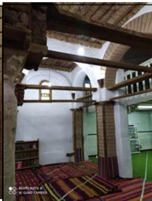
Fig. 33 le plats fond avec les troncs palmier
