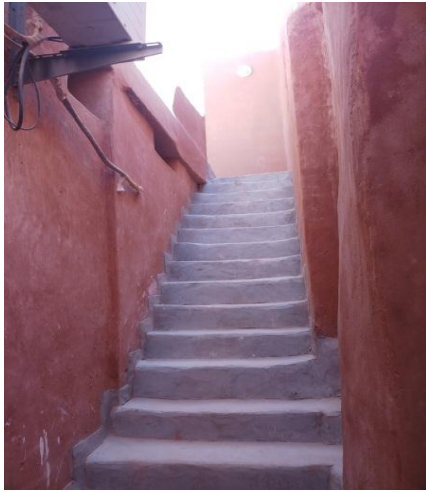
Fig. 61 L'escalier vers le 1ère étage
