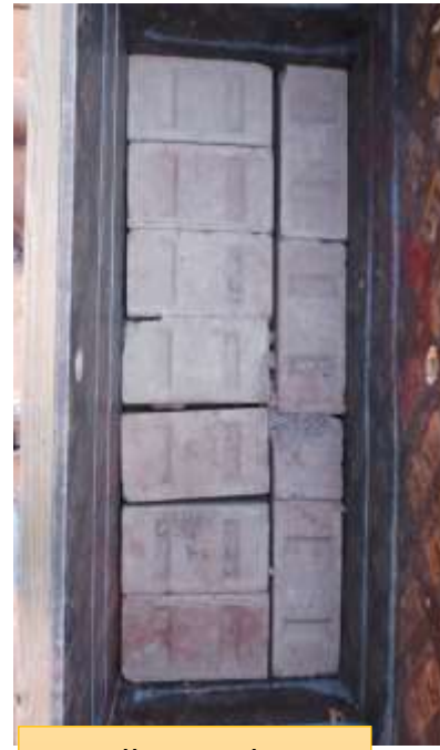
Installation du sous bassement pour protéger le mur de la pluie (briques)
