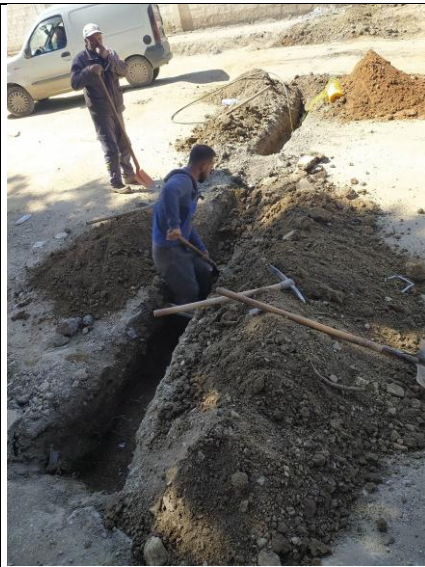
Fig. 33 : traitement de réseaux d'AEP
