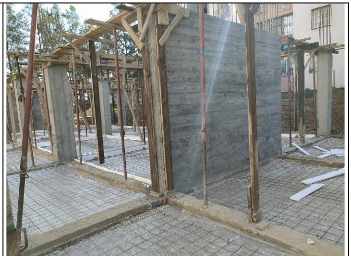
Fig. 18 : treille soudé et le nylon sous le treille soudé
