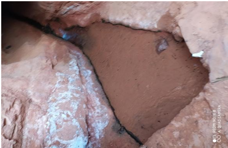
Fig. 35 la galerie de foggara
