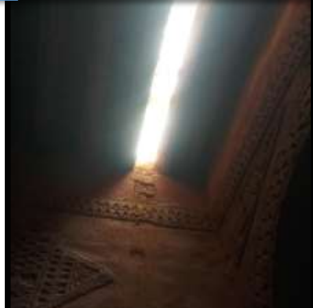
Source de lumière provenant du plafonds grâce à des bouteilles de vins
