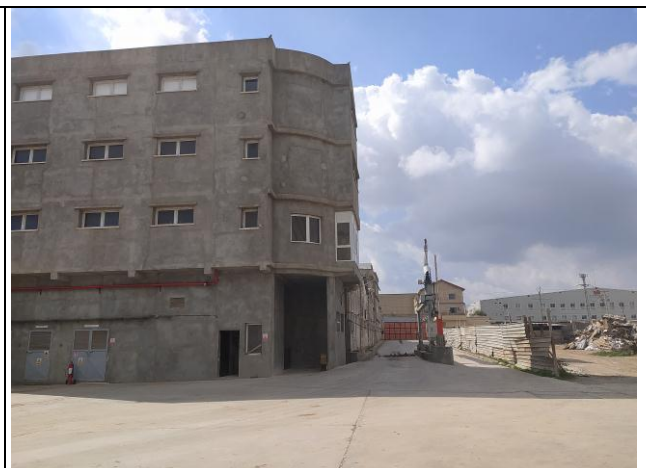
Fig. 12 : nouvelle bâtie dans l'usine
