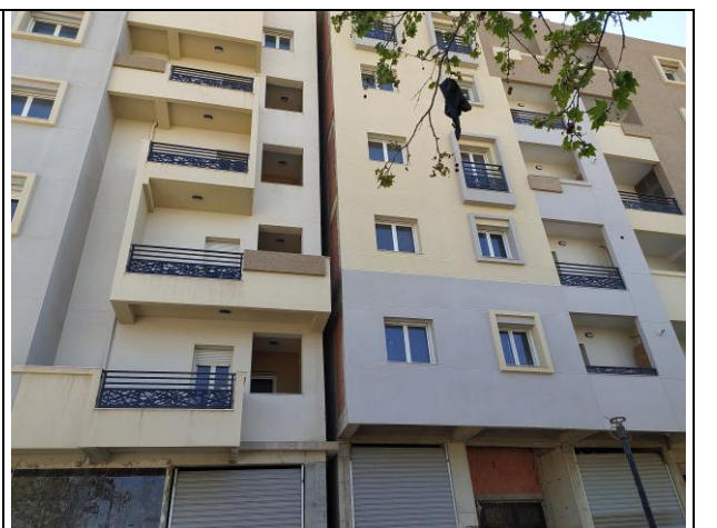
Fig. 24 : la façade d'immeuble
