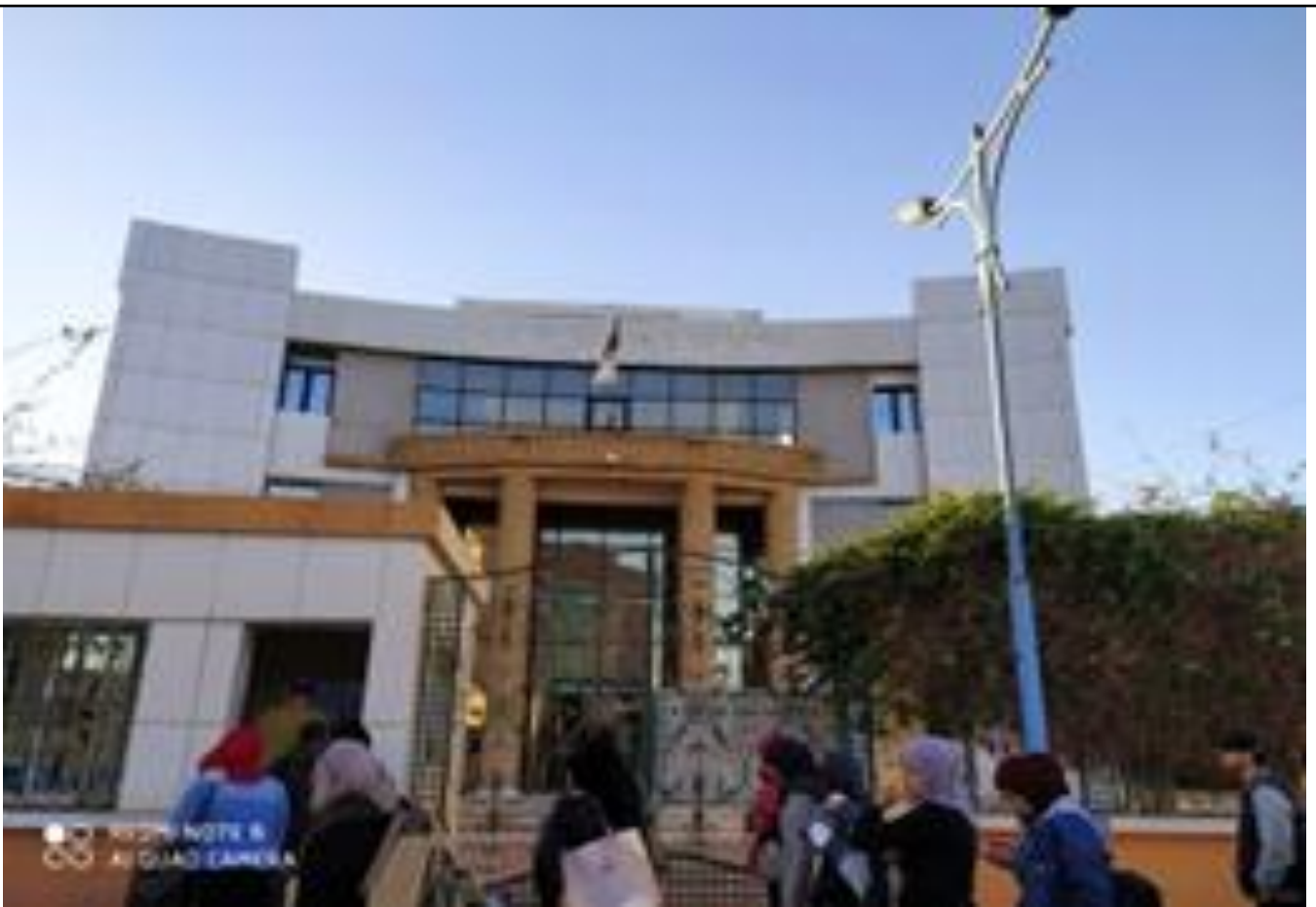
Fig. 20 la façade principale de la duc
