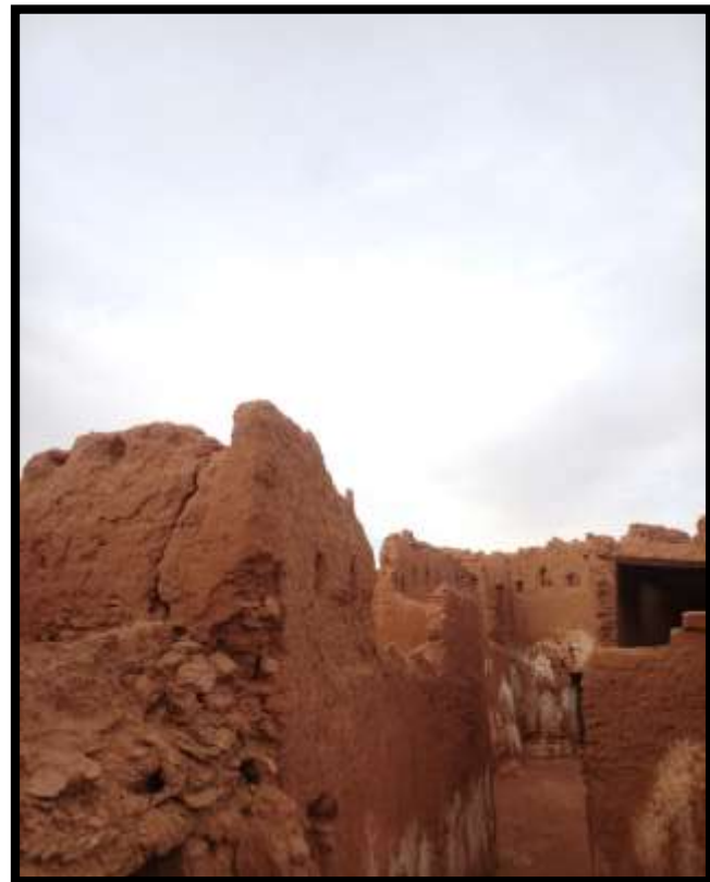
Fig.4: vu sur une rue étroite du ksar
