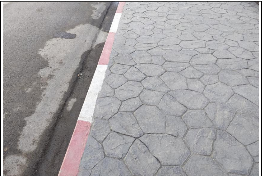
Fig. 34 : la mise-en places de voiries
