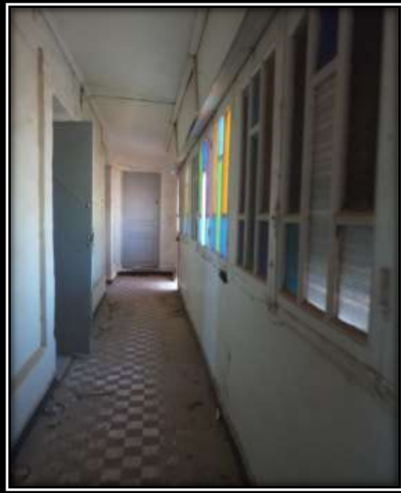
Fig.43: Vu à l'intérieur d'un couloir au niveau du 2 ème étage
