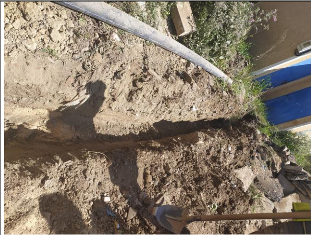
Fig. 31 : traitement de réseaux d'AEP
