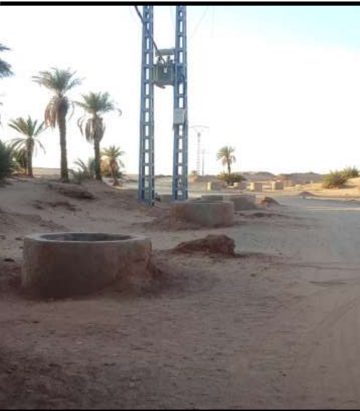
Fig.23: les houassi de la foggara Badgha construit et couvert en parpaing
