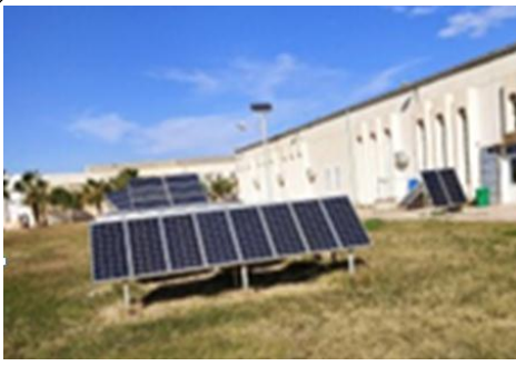
Fig. 15 les panneaux solaire
