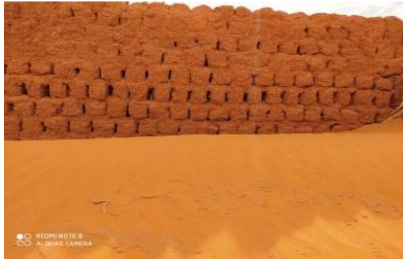
Fig. 26 mur construite en adobe
