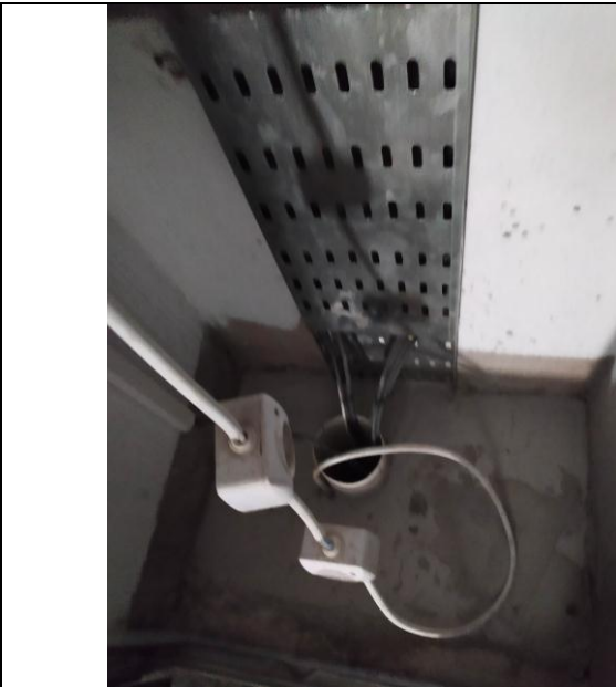
Fig. 27 : la mise en place de la colonne d'électricité
