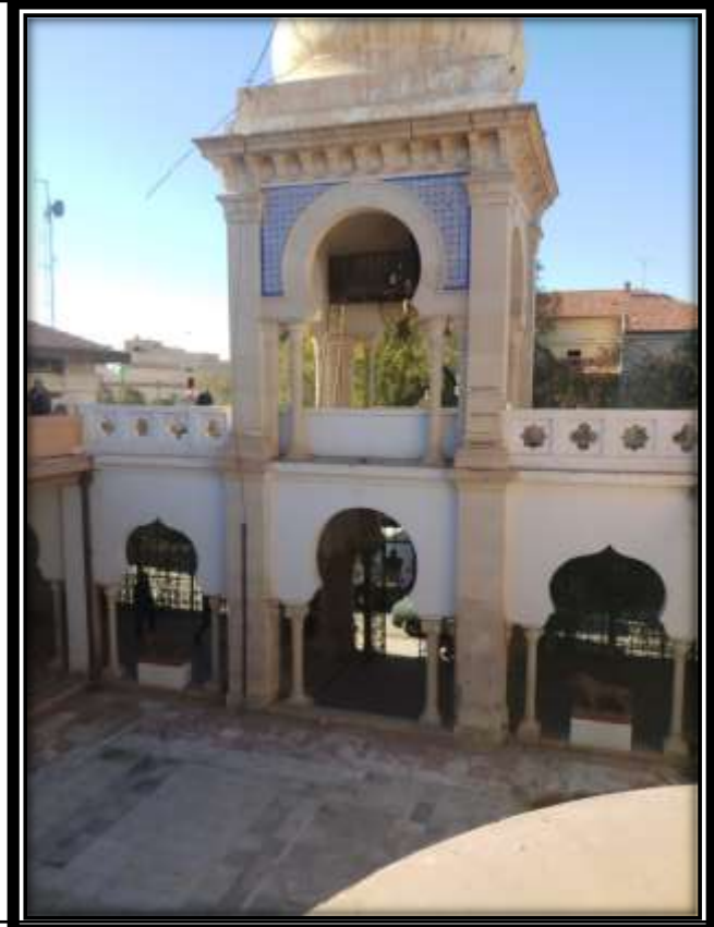
Fig.42: vu interne de l'ancienne apc de Biskra
