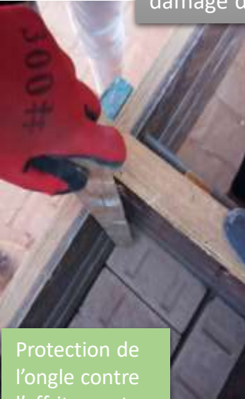
Damage de la couche de terre (Mélange)
