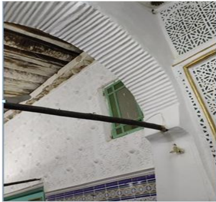
Fig. 45 les poteau et l'arc
