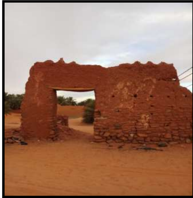
Fig.2:porte du ksar
