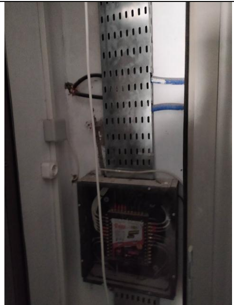
Fig. 28 : la mise en place de la colonne du parabole
