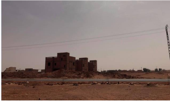
Fig. 64 : Vue sur la rive Sud-ouest du Boulevard du Sbuâ vu depuis le site, source : Les Auteurs
