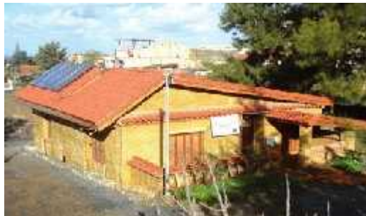
Figure 47: Habitation de haute qualité énergétique à Souidania (projet Med-Enec)
