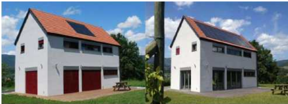
Figure 22:Façades « Sud » de la maison Chloé originale (gauche), et extension (droite)
