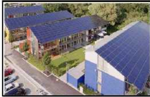
Figure 9 : logements collectif à énergie positive à Freiburg, Allemagne.
