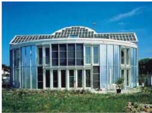
Figure 18 : Façade sud de la maison Hölken
