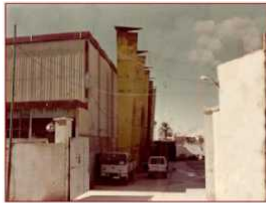
Figure 43: Central électrique de Laghouat
