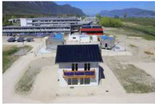
Figure 19: Maison I-BB de plateforme INCAS à Chambéry
