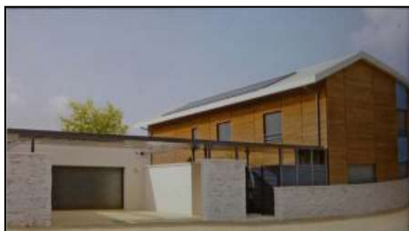
Figure44 : présente mur de clôture en pierre
