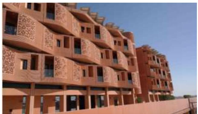
*Figure N°32 : des brises soleil et moucharabieh au niveau du bâtiment*
