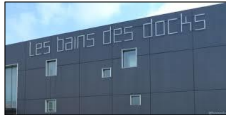
Figure 122: le traitement de façade. Source : ouest-France.fr
