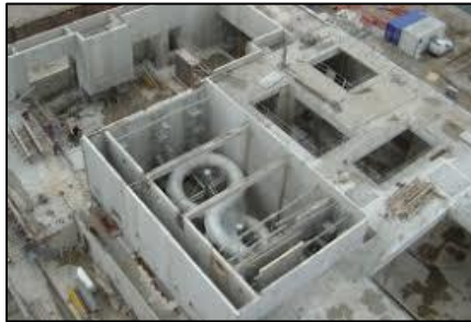
Figure 121 : les bains des docks entrain de construction.
