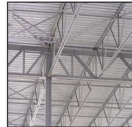
**Fig86**Poutre en treillis
