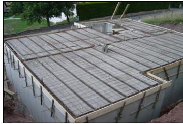
**fig88**plancher à corps creux
