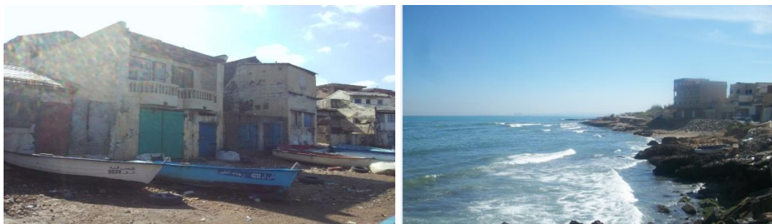
Figure 42 : vue sur le cadre bâti a Fouka marine et la façade maritime (source : auteur)
