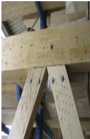
Figure 62: vue sur les détails de système treille de poutre kerto (source WOOD NUMÉRO 9 – STRUCTURES GRANDES PORTÉES)
