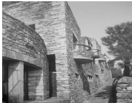
Figure 41 : Maison de bourg en pierre à Cannero, Italie (source : construction de maçonnerie)
