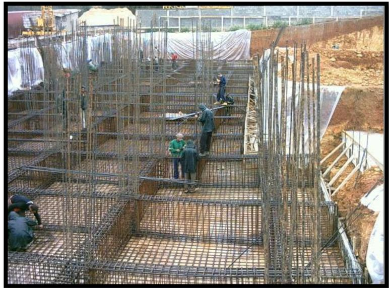
Figure 99: Fondation en radier en travaux.
