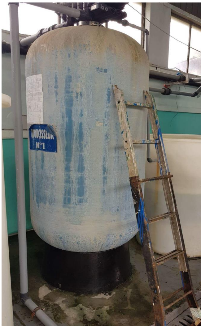
Figure 38 : un adoucisseur dans la station SMP.
