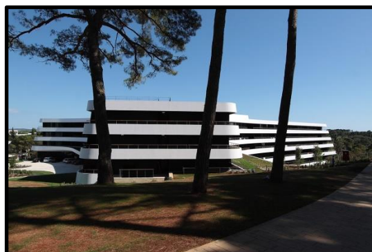
Figure A.04.6 : Photo montrant la façade de l'hôtel, Source : Google Images.
