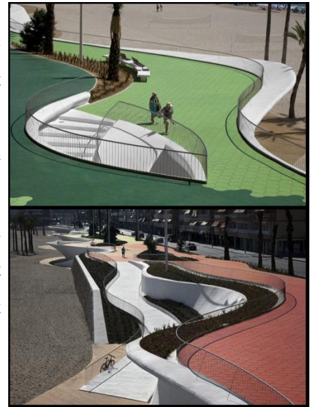
Figure II.6.4 : vue sur les rampes et les emmarchements, src: OAB Lab
