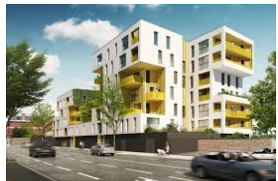
Habitat colectife exemple architectural source : auteur 2016
