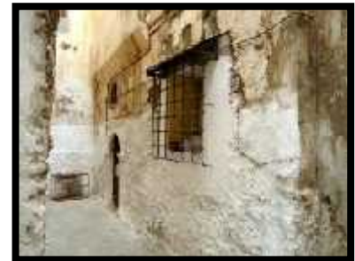
Figure 1.29 : Mur en pierre
