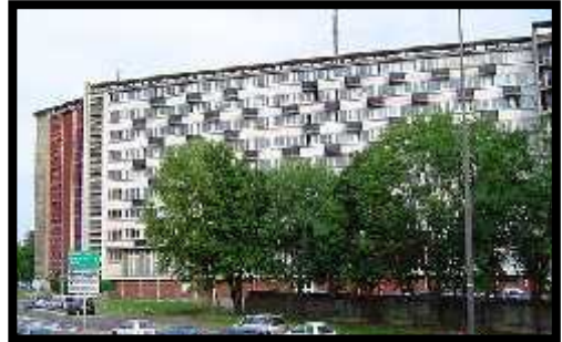
Figure 1.58 Résidence Jen Zay en France
