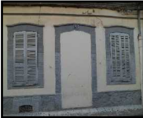
Figure 3.18 la brique pleine sur l'école des orangers à Blida (à côté du projet)
