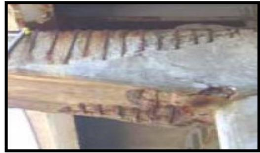
Figure43 : phénomène de corrosion d'un poteau en béton armé
