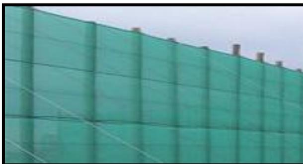
Figure 41: : barrières brise-vent artificielles
