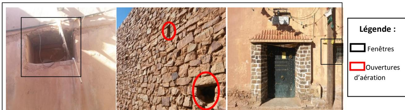
**Figure n°15** : Différents vues de la façade extérieure.
