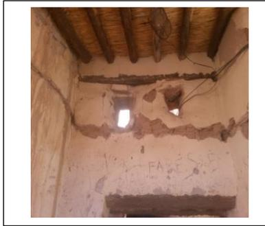
**Figure n°29 :** Illustration des ouvertures d'aération.
