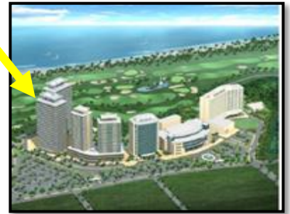
Figure32: Rapport avec l'environnement immédiat
