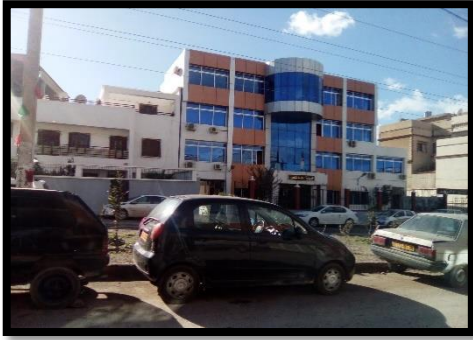
Figure 3.29 : Direction du commerce/ Source : auteur
