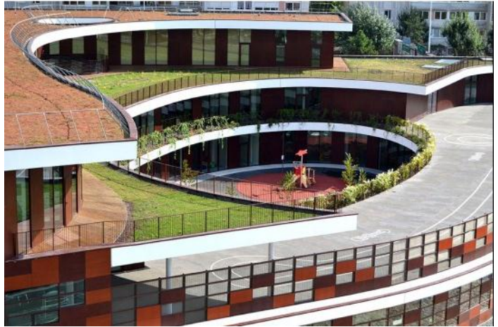
Figure 21 : Vue sur la cour du groupe scolaire et centre de loisir de Bobigny
