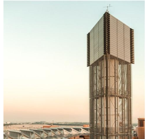
Figure 14 : Tour a vent urbaine a Masdar city
