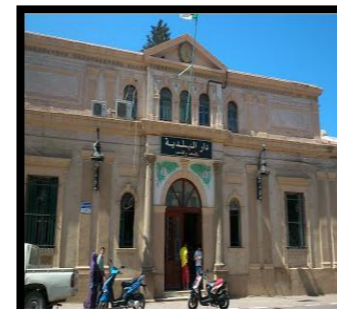
Figure 3-44 : la voie est alignée par des équipements.
