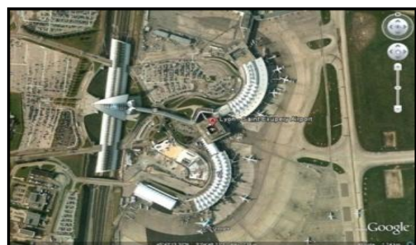
FIG2.18: vue aérienne sur la gare de SATOLAS. Srce : la revue architrave, novembre2007n 158.
