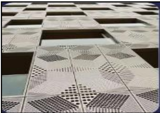
FIG 2. 41:les panneaux coulissants de la façade. Srcce : Requalification des grands ensembles2012.
