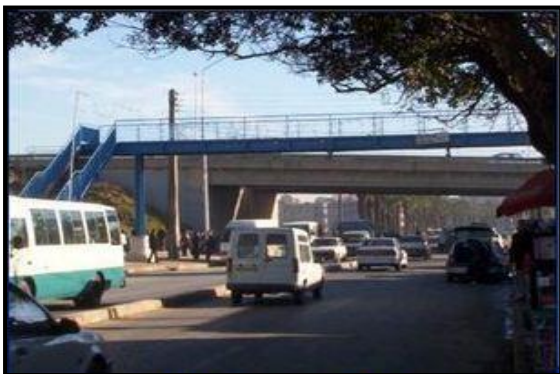
FIG3.23: Photo du nœud principale N°1 Srce : auteurs 2016
