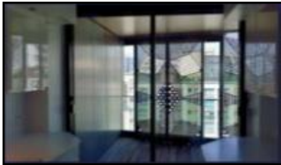
FIG 2. 43 : la vue interne de la façade . Srce : Requalification des grands ensembles2012.
