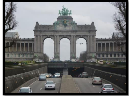
Figure1: tunnel du Cinquantenaire à Bruxelles, Belgique.
