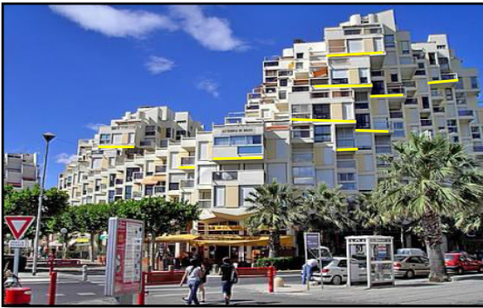
Figure2:Pare-soleil horizontaux permettant l'ombrage des façades orientées au midi, ils sont inefficaces sur les façades orientées à l'Est et à l'Ouest.
