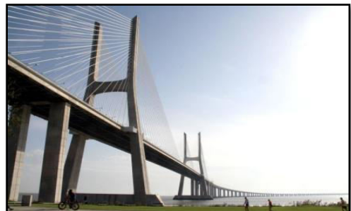
Figure4: Câbles de retenue
