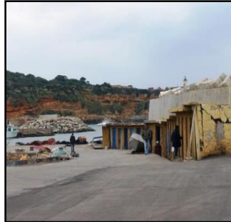
Figure2:Lieux de stockage
