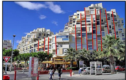
Figure3: Pare-soleil verticaux protègent les murs extérieurs de l'ensoleillement direct permettent une ventilation par convection le long de la paroi extérieure du bâtiment.
