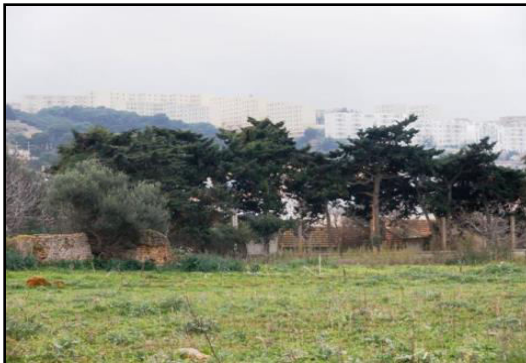
Figure3: Construction sur la falaise qui ne respecte pas le PAC
