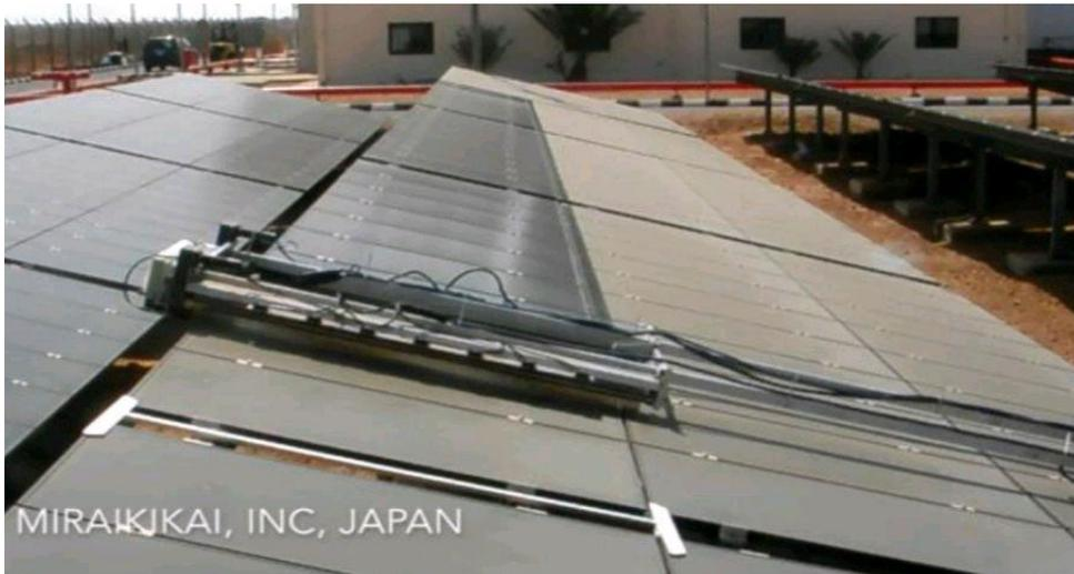
**Figure 3. III :** Système nettoyeur automatique de panneau photovoltaïque
