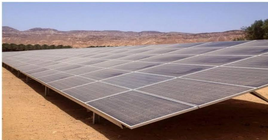
**Figure 2. IV :** Accumulation de la poussière sur des panneaux PV
