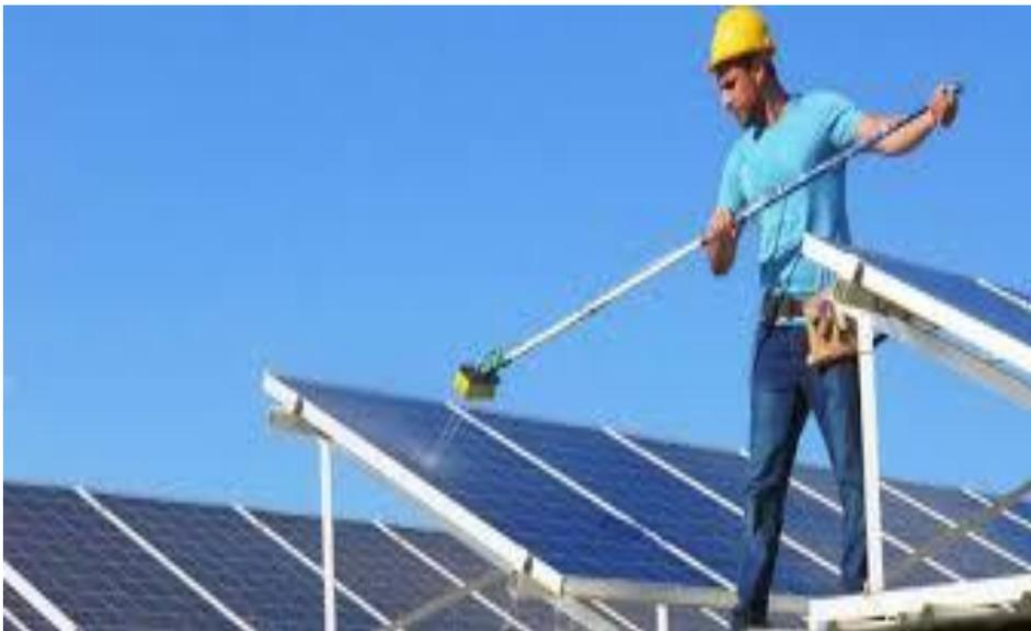
**Figure 3. I :** Nettoyage manuel de panneau photovoltaïque
