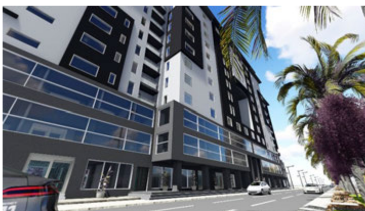
Fig.03.43. Modénature / Srce : Auteur 2016
