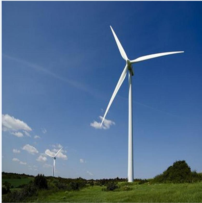
**Fig. I. 6** : Aérogénérateur à axe horizontal
