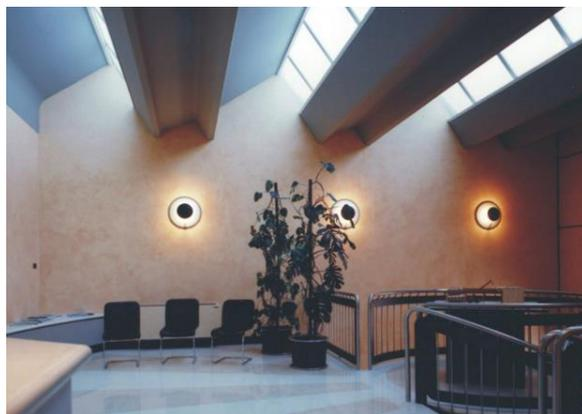
Figure 33: Couverture préfabriquée en béton armé sheds préfabriqués.
