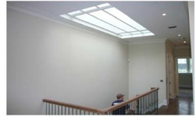
Figure 21: Exemple d'éclairage zénithal de type tabatière. ( source : <http://ameliorerchezmoi.com>)
