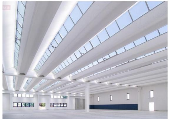
Figure 32 : couvertures préfabriquées en béton armé sheds préfabriqués.
