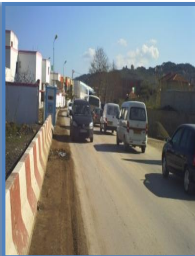
Fig 10: Accès Ouest Source : Prise par le groupe
