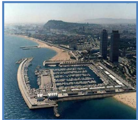
Fig 1: Le Port Olympique de Barcelone, Espagne Source: http://www.europetrotteur.com/
