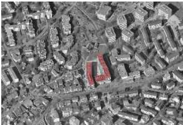
Fig. 19 : Vue aérienne du projet
