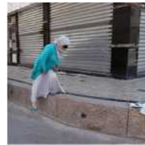
Photo 03 : Des trottoirs surdimensionnés
