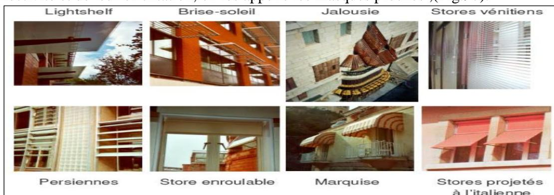
**Figure 97** : Types de brises solaires architecturales ; **Source** : Yannick ; Sutter, et al. 2014
