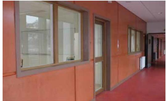
**Figure 91 :** Variation de FLJ d'un local accolé d'un couloir avec une ouverture et un lanterneau ;
