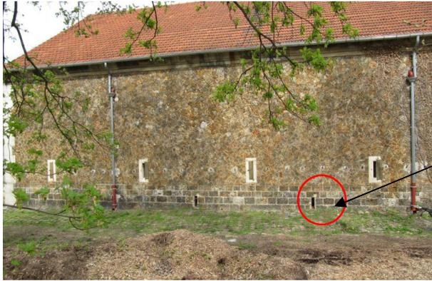
Fig 2.62 : Vue les différents bouches d'aération
