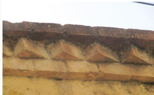
Fig.3.34: Brique pleine au niveau de la corniche
