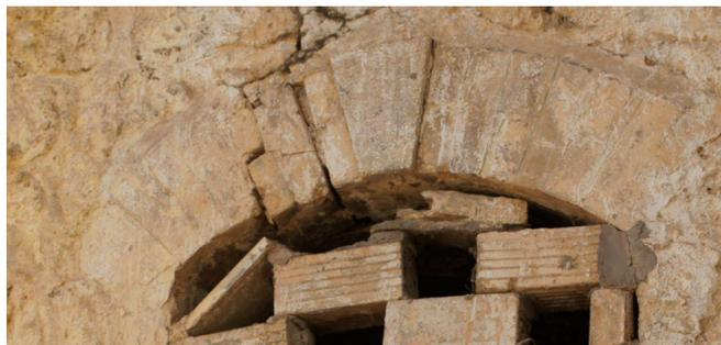
Fig.3.33: brique pleine au niveau de l'arc surbaissé
