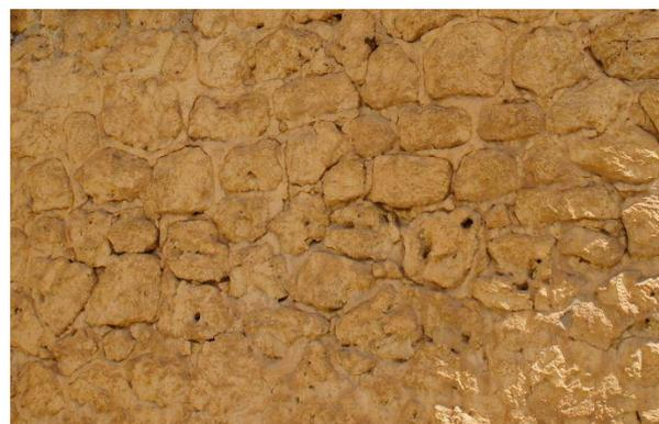
Fig.3.35: vue sur le mortier utilisé sur le moellon
