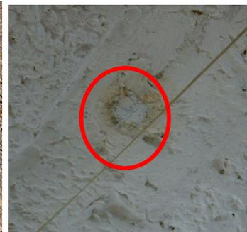
Fig.3.28: Bouche d'aération cimenté de l'intérieur
