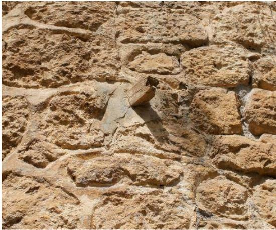
Fig.3.36: solive en bois(1) visible sur la partie haute du mur extérieur
