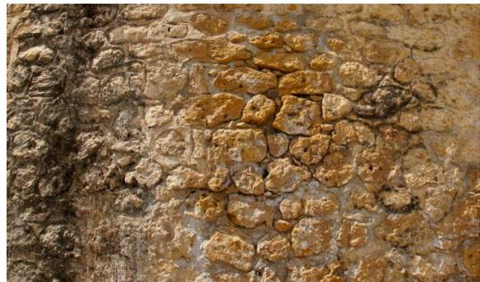
Fig.3.29: Mur extérieur en moellon
