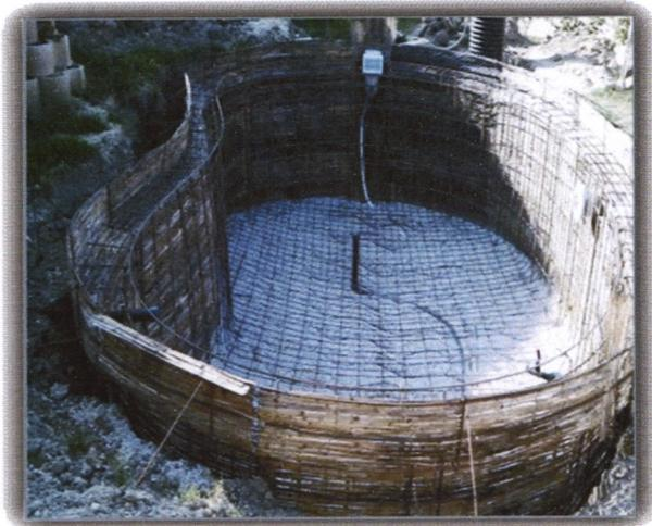
1. après avoir fait le traçage et l'emplacement de la piscine on pose le ferrailage et les canalisations.
