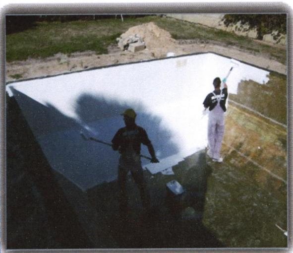
3. application des couches d'enduit pour béton afin d'empêcher la migration des algues et assurer l'étanchéité .
