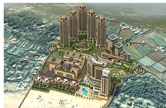
Fig : 22.2:vue générale sur les Cinq tours sce : http://www.betzerarga.net/forum-el-djazair.html
