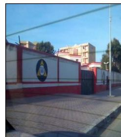
Fig.20.03.siège de la protection civile de Ain Benian. Srce. prise par l'auteurs 2015
