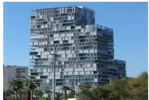
Fig : 11.2: vue en façade sur la tour Srcce : livre « Haut densité (habitat contemporaine) »
