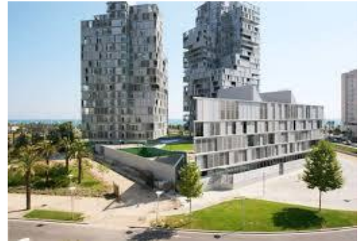
Fig : 10.2 : vue générale sur le projet Srcce : livre « Haut densité (habitat contemporaine) »
