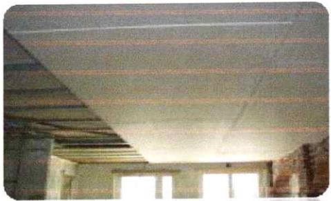
Fig118. Faux plafond en plaques de plâtres
