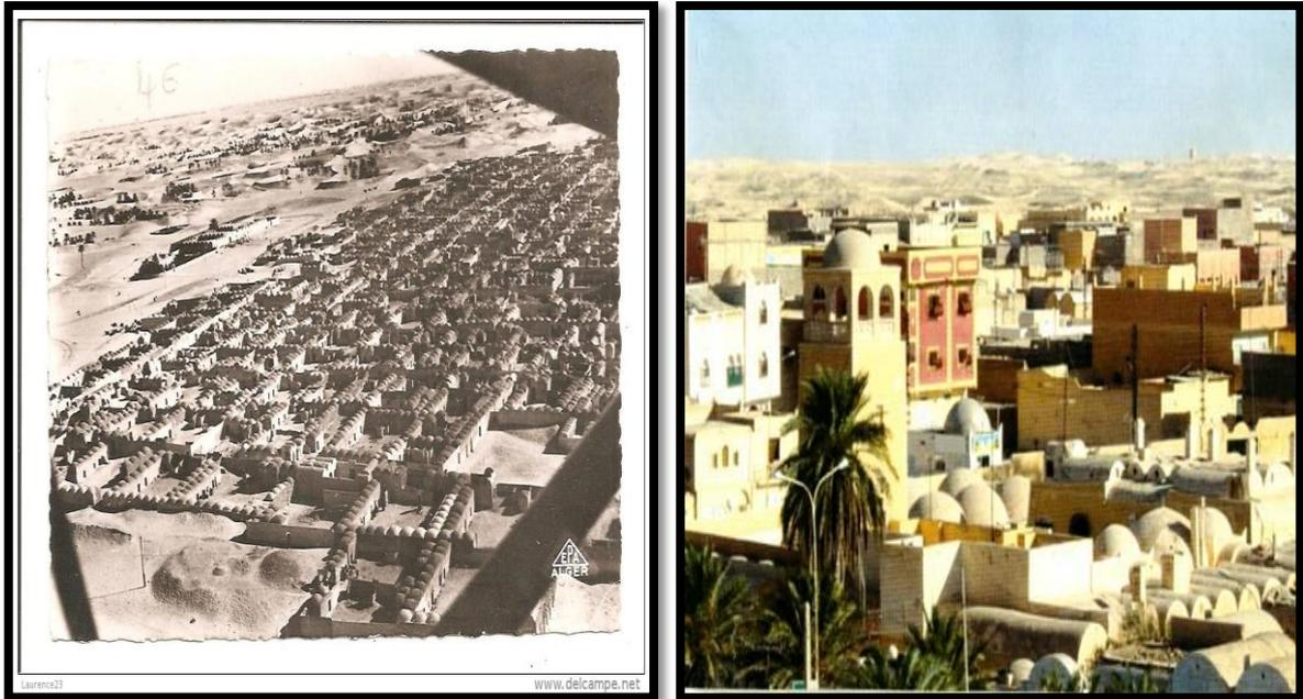
**Fig 3.16 / 17:** Toiture en voutin et coupole
