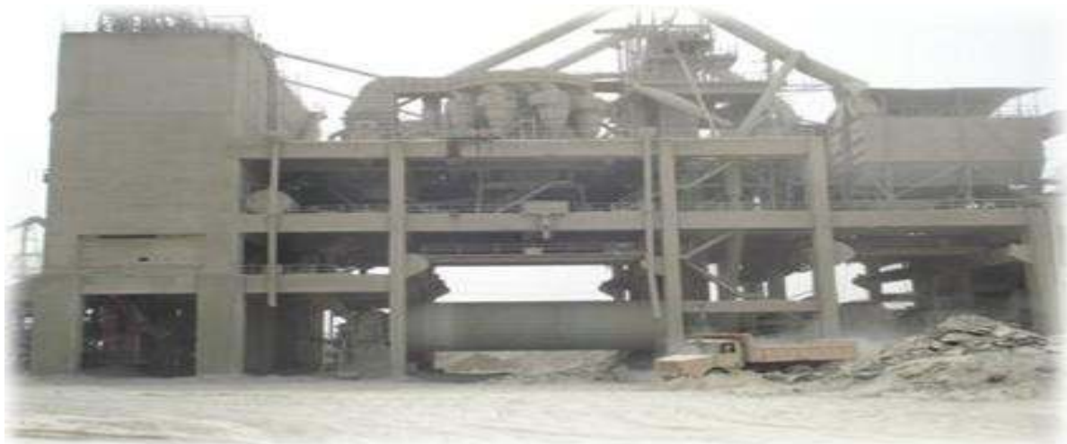
Figure 7: Le broyeur à boulets [6]
