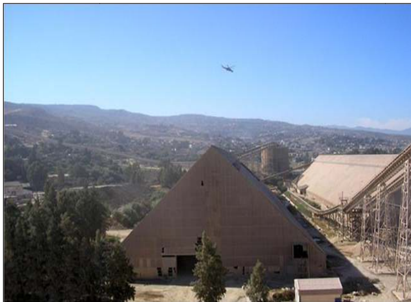
Figure 6 : hall pré homogénéisation [5]
