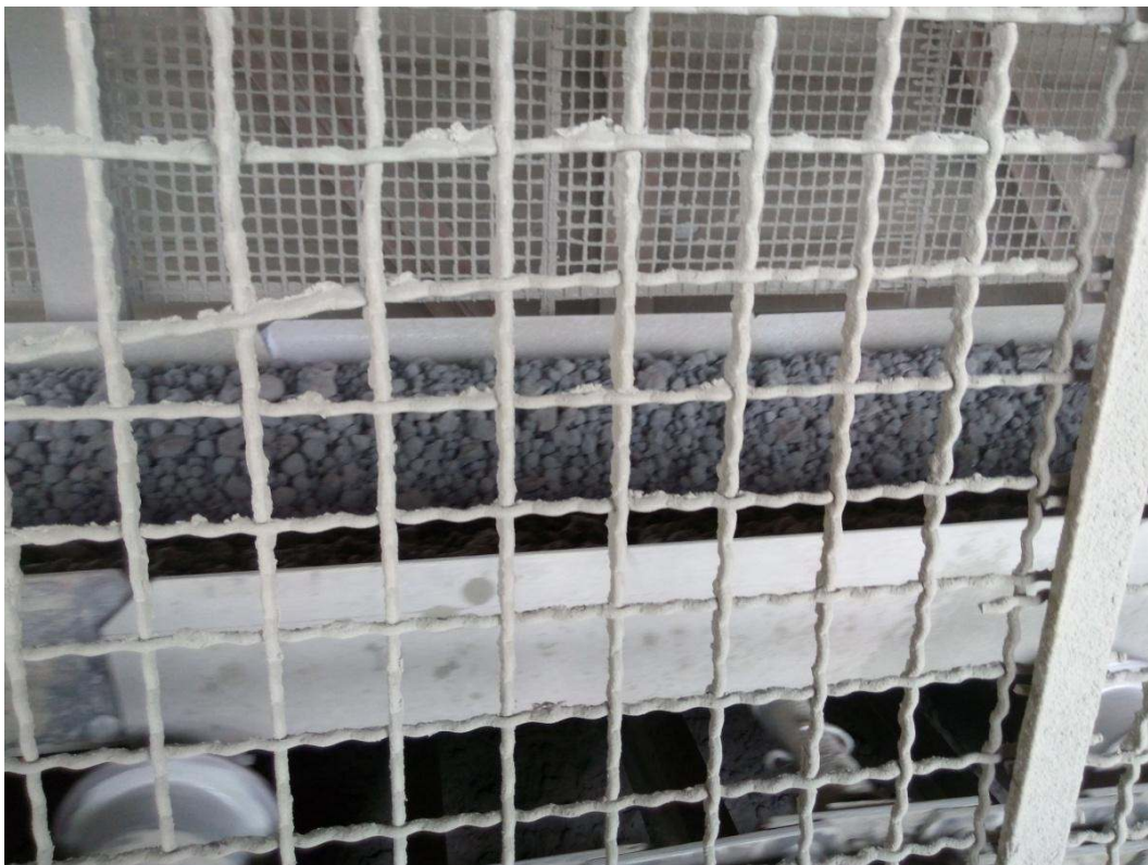
Figure26:Chaine Tablier T15(autre façade)
